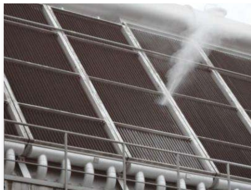
Limpieza de Aero refrigerantes Via seca
