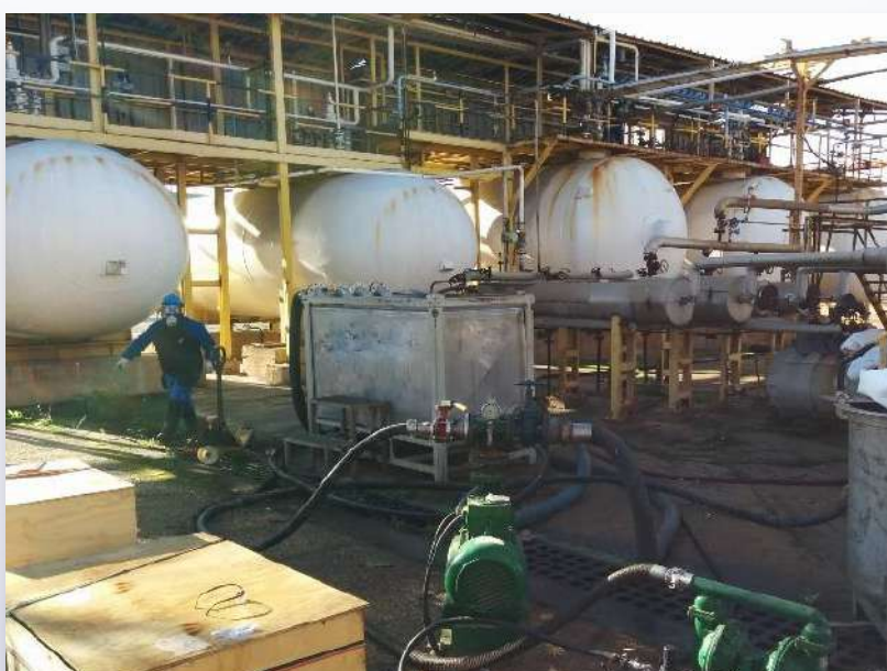
Desgasificado y limpieza de depósitos
