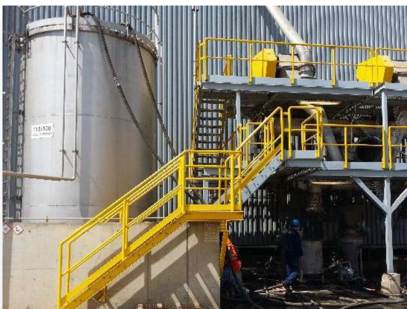
Inertización y limpieza de Tanques químicos
